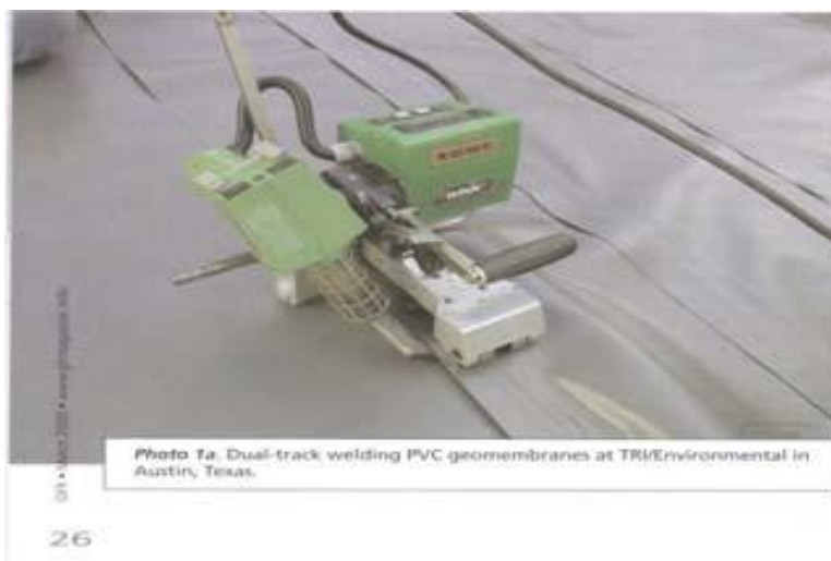
Fig. 2 - saldatura a doppia pista
