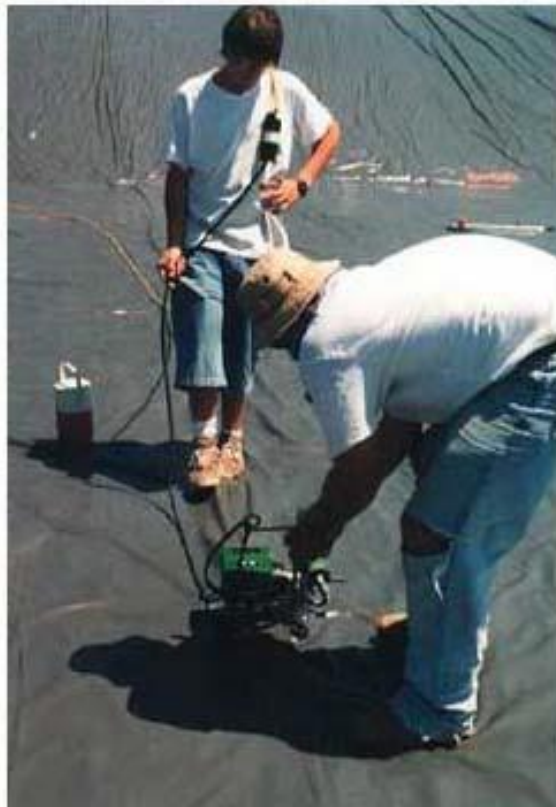
Fig. 1 – saldatura a caldo
